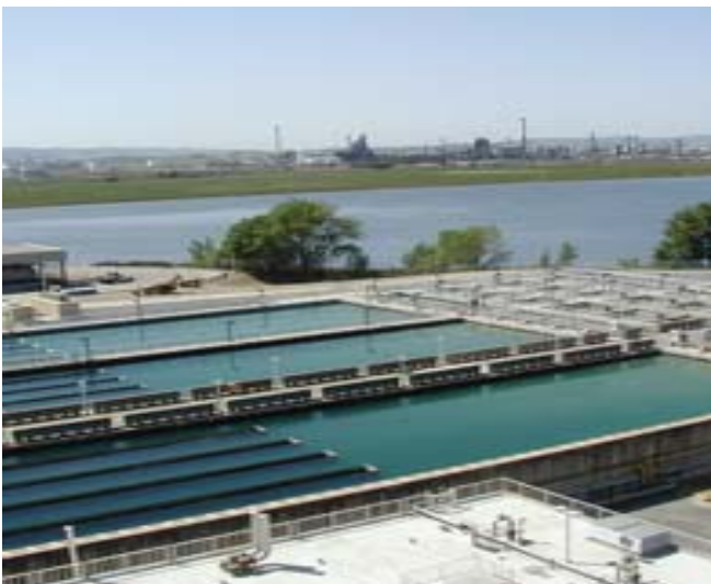
Usina de dessalinização da água
